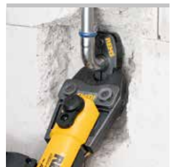
REMS anillo de prensar 45° (PR-2B) Patent EP 2 774 725
