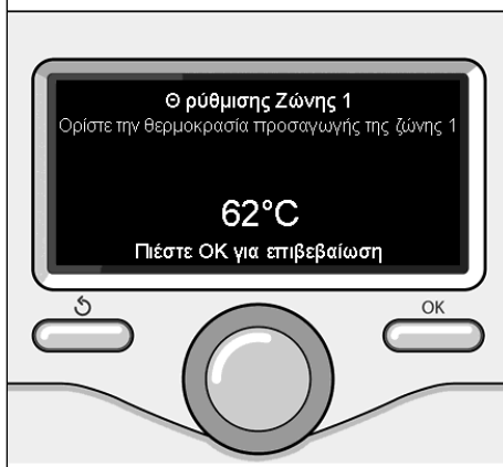
Τροποποίηση θερμοκρασίας ζεστού νερού θέρμανσης
